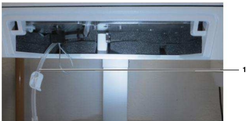
Fig. 78 Tubo de drenagem
